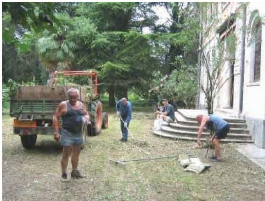
Un momento dei lavori
