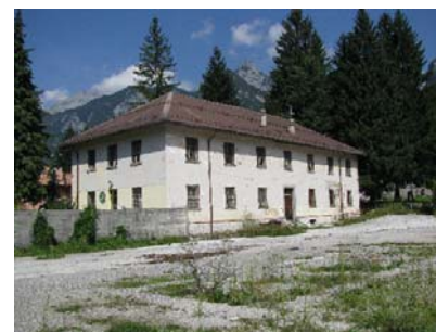
Pontebba - Caserma 8° - Palazzina comando dall'interno della piazza d'armi
